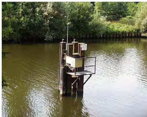
Abb.3.2.1. -2: Entnahmestelle im Teltowkanal
