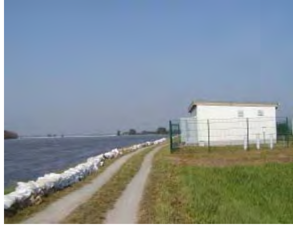
Abb. 3.2.3.-3: Messstation Cumlosen während des Elbehochwassers 2002. Neben der Nutzung der Station zur Erfassung der Wasserbeschaffenheit ist ebenfalls die Anwendung als Depositionsmessstelle anhand der seitlich der Station befindlichen Sammler zu erkennen.
