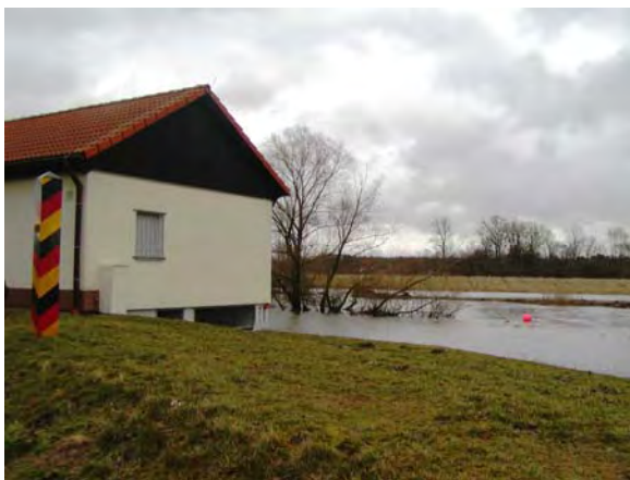
Abb. 3.2.3.-6: Messstation Ratzdorf vor der Neiße- mündung in die Oder
