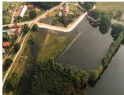
Bild 2: Notdeich zum Schutz der Ortslage Weissen, LK PR
