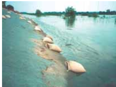
Bild 14: Aufgeschwommene Folie durch unzureichende Beschwertung (nur 1 Lage Sandsäcke)
