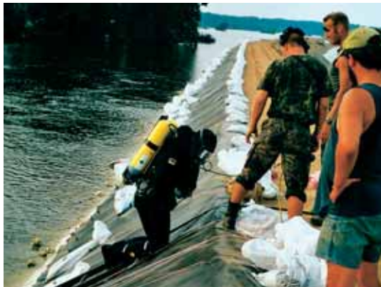
Bild 34: Mit Foliendichtung gesicherte Böschung (Elbdeich zwischen Müggendorf und Cumlosen) 2002 Die Sandsäcke sind mit schwachen Seilen auf der Deichkrone befestigt
