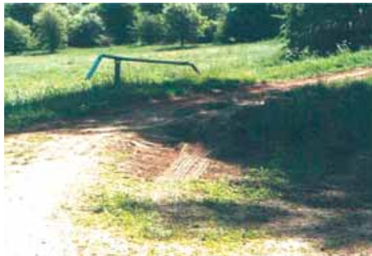
Bild 5: Zerstörte Grasnarbe (Haveldeich) durch Umfahren der Deichsperre
