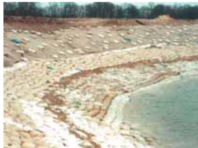
Bild 15: Flächendeckende Sandsackauflast (Baustellensicherung) wasserseitig Elbdeich 1994
