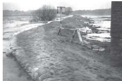
Bild 21: Aufkudung und Sickerstellenverbau am SW Witzke II (Gr. Havelländ. Hauptkanal 1982)
