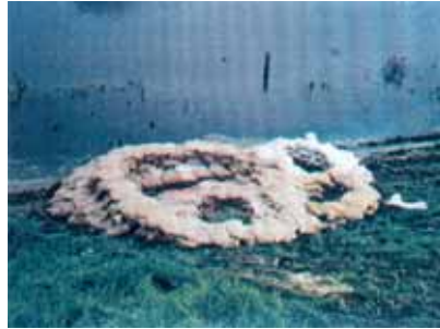
Bild 17: Quellkade Elbdeich August 2002
