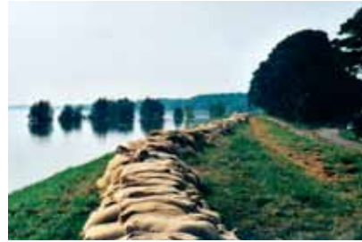
Bild 20: Aufkudung des Elbdeiches im Bereich der Ortslage Gnevsvorf (August 2002)
