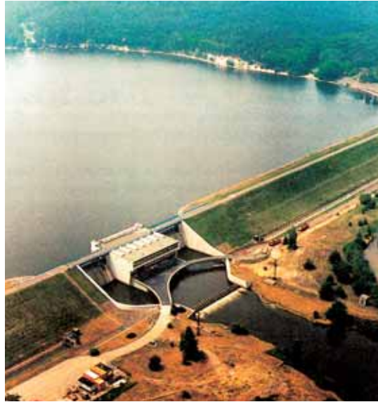
Bild 3: TS Spremberg (Komplexbauwerk)
