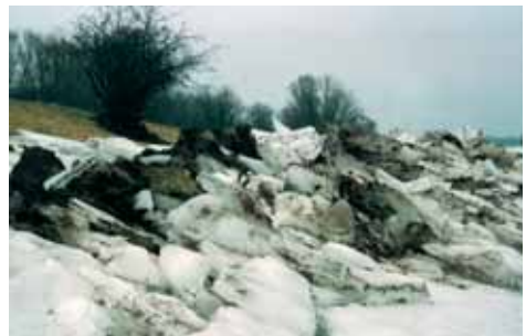
Bild 8: Böschungsschälungen durch Eis am Oderdeich (März 1994), die durch den Wachdienst rechtzeitig erkannt wurden
