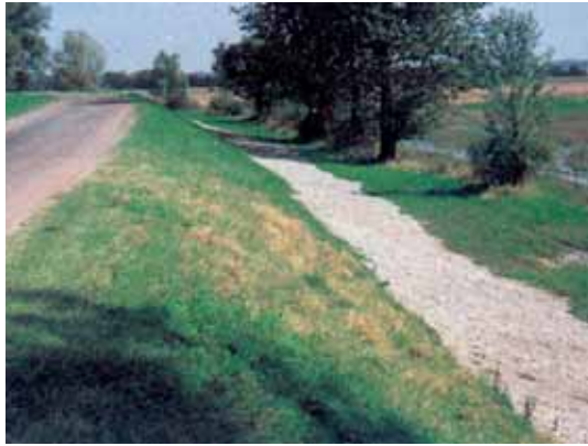
Bild 32: Auflastfilter bei aufgeweichten Böschungen aus Filterkiesen, Korngröße 4-32 mm, Oderdeich D-km 25,7 bis 29 1997
