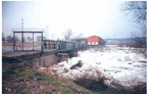
Bild 27: Eisversetzungen unterhalb des Wehres Widuchowa (Oder Jan. 2003)
