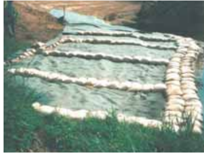
Bild 13: Elbe bei Mödlich (Baustellensicherung 02/1995-12/1995)
