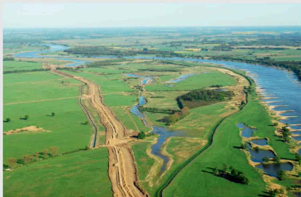
Neudeich im Bau. Der mittlerweile fertiggestellte Deich ist jetzt bequem mit dem Rad befahrbar und bietet spannende Einblicke. (Foto: Jochen Purps)
