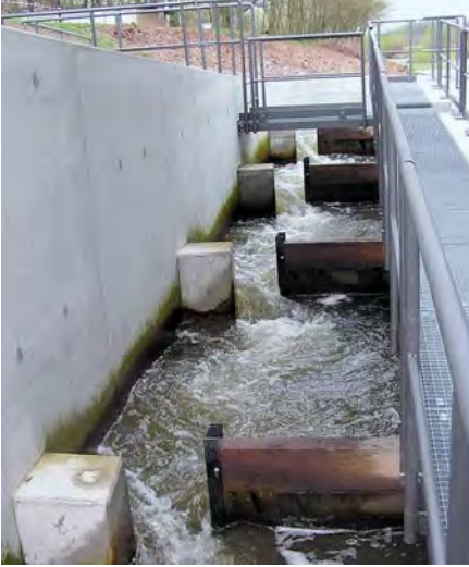
Abb. 5 Schlitzpass als Fischaufstiegshilfe an Querbauwerken
