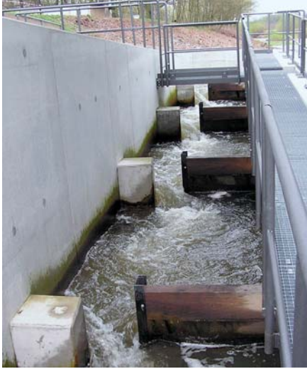
Abb. 5 Schlitzpass als Fischaufstiegshilfe an Querbauwerken
