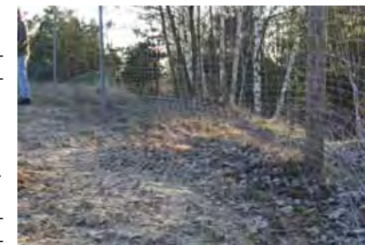
Unterwühlschutz mit Knotengeflecht am Boden
